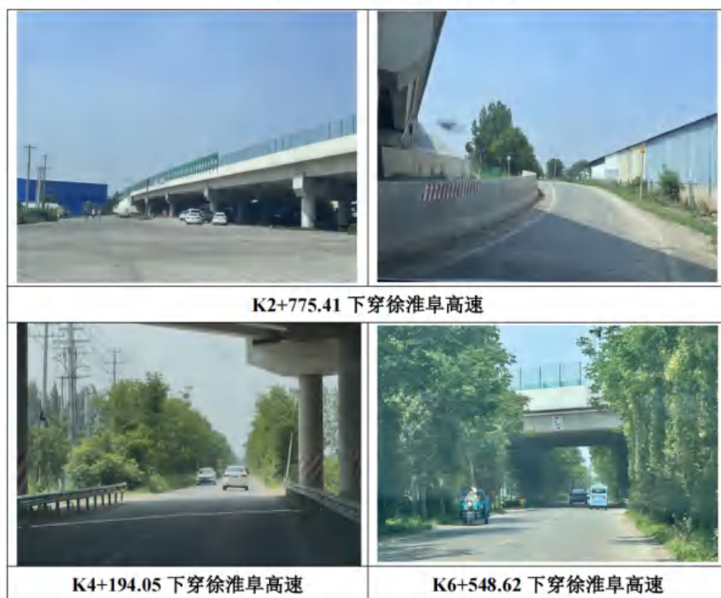
图 2-4 本项目下穿徐淮阜高速淮北段现状照片
