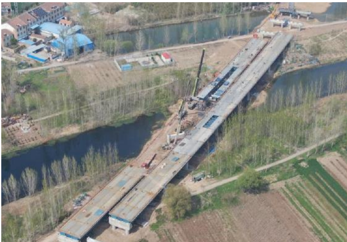
图 3-19 铁白路桥东侧在建高铁桥
