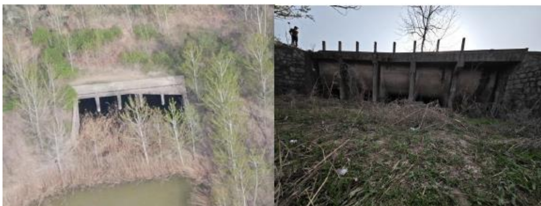
图 3-10 巴河地下涵现状
