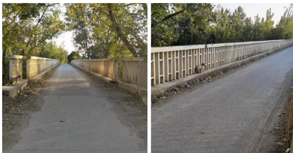
图 3-13 梁庄南桥现状
