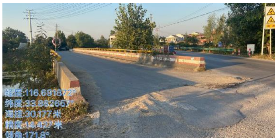
图 3-14 钟王路桥和滩石路桥现状
