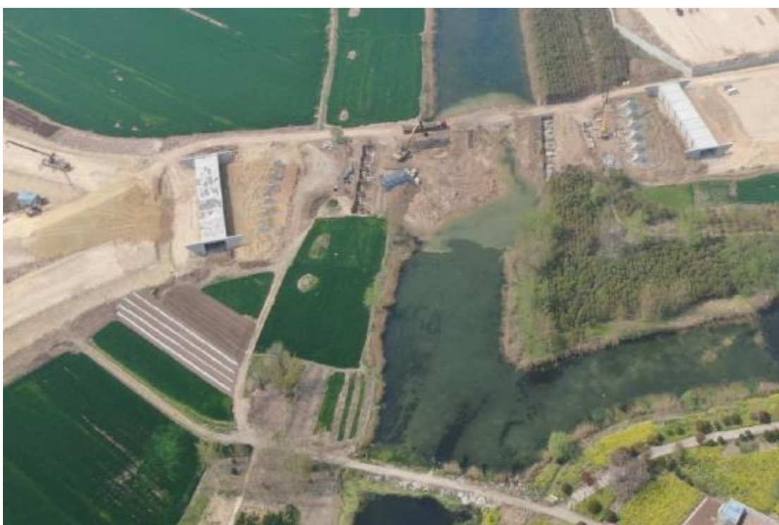
图 3-17 在建王埝村高速公路桥现状
