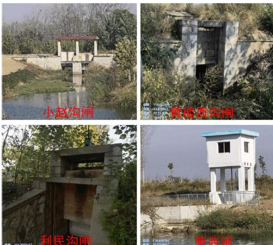
图 3-8 支流涵闸现状
