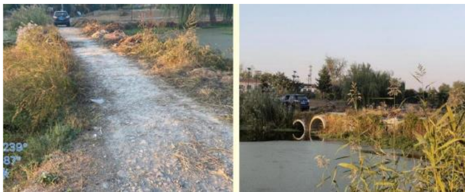
图 3-12 王埝桥跨河涵管桥
