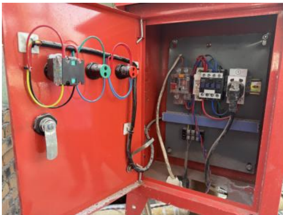
图 6 碱化池污水泵开关箱
