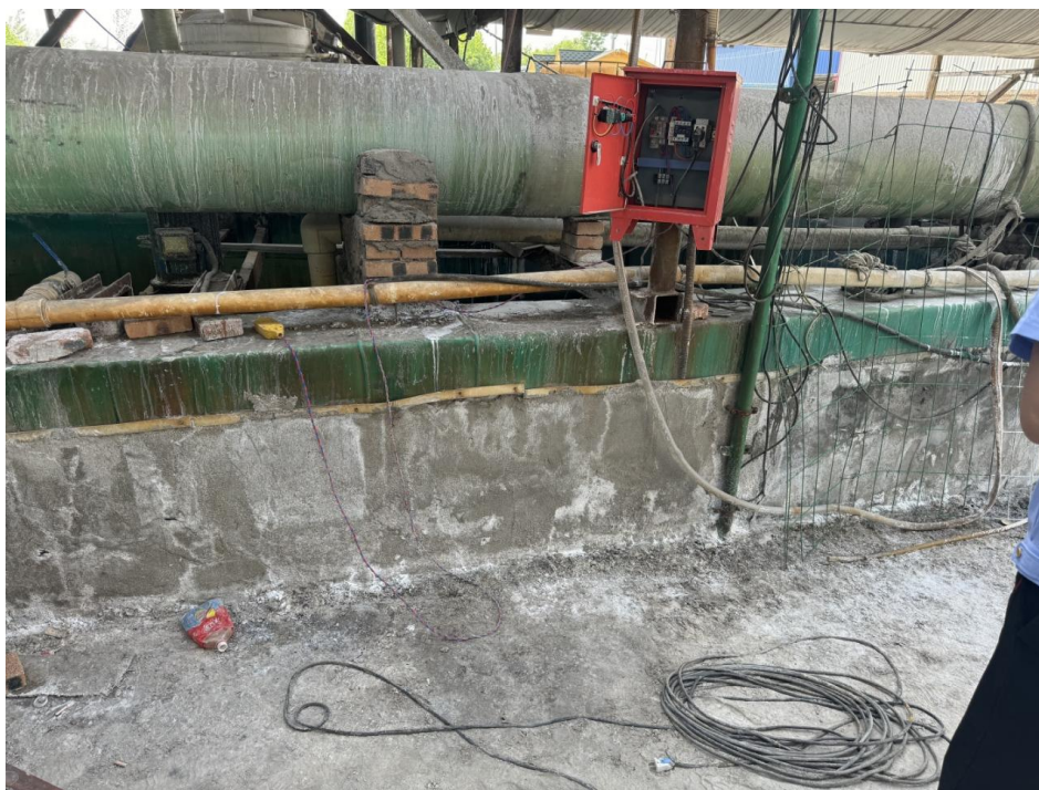
图5 角磨机临时电源通过 2 处插排转接
