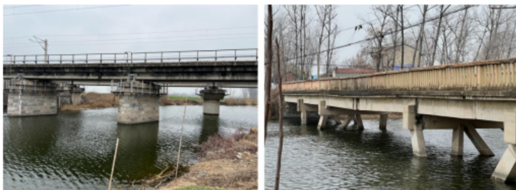
图 3-7 常沟临涣镇段桥梁建筑物现状
