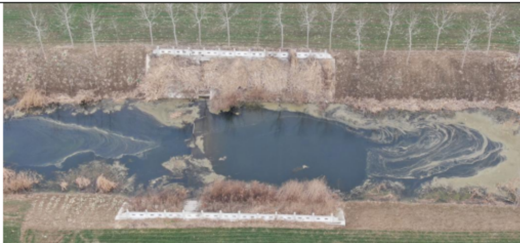
图 3-6 土营东桥拦水坝现状
