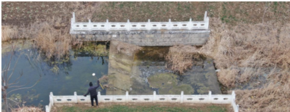
图 3-4 草寺拦水坝现状
