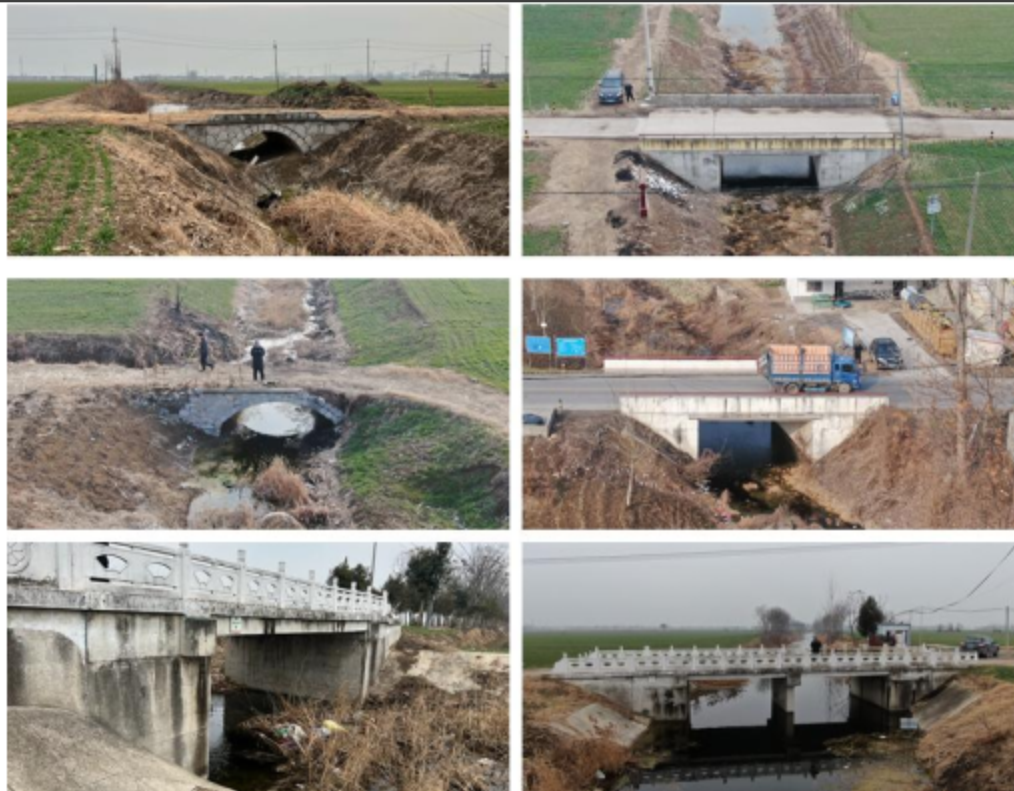
图 3-3 常沟铁佛镇段桥梁建筑物现状片
