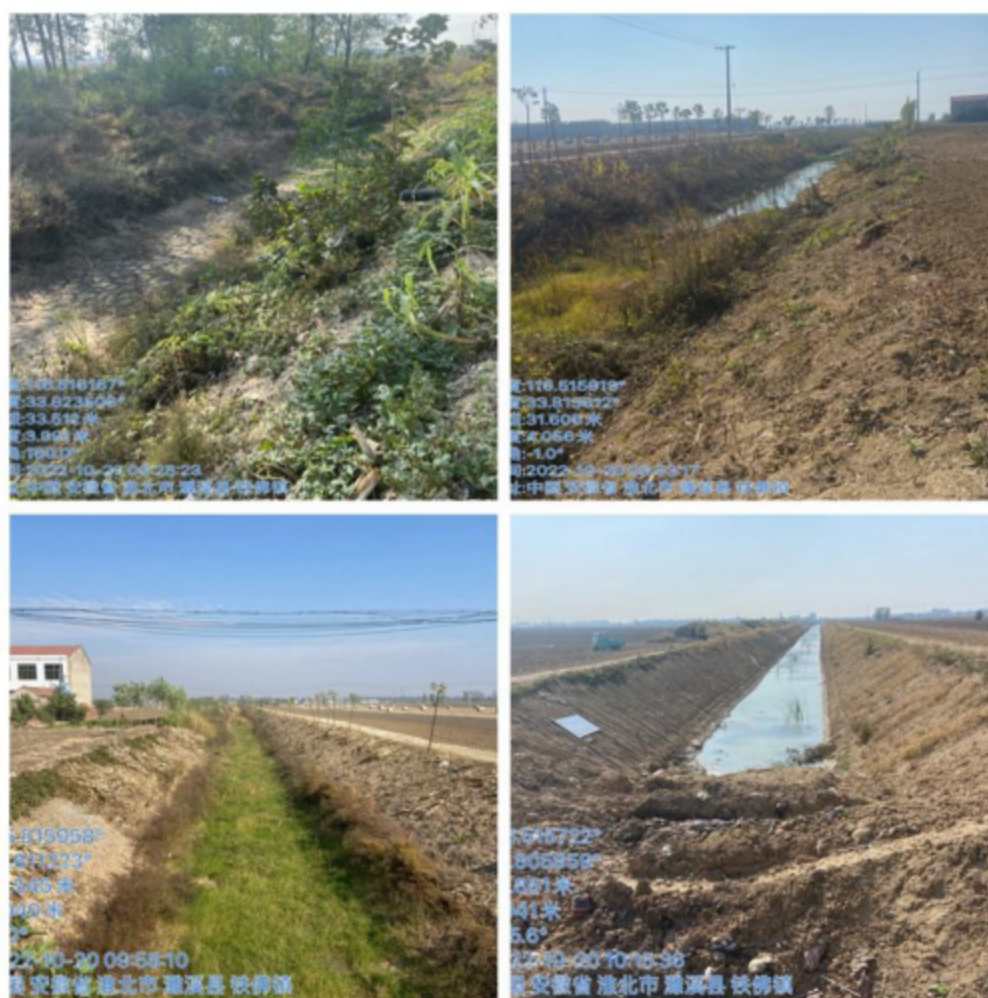
图 3-2 常沟铁佛镇段干流现状照片
